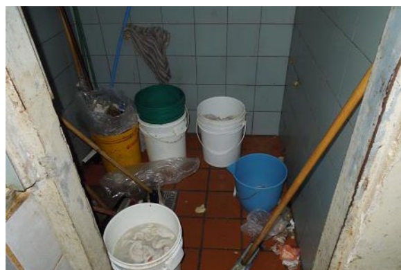
X Baño de un establecimiento en malas condiciones.
