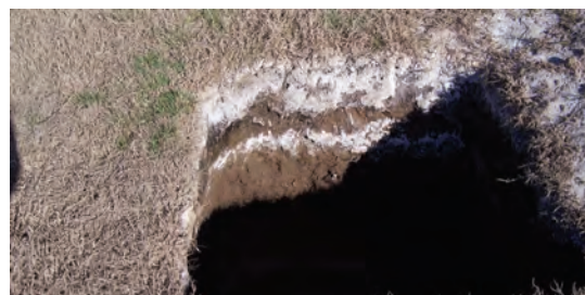
Alarmante ascenso capilar de sales en un perfil deprimido.
