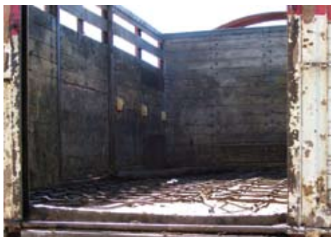
Figura 20: Piso en mal estado y peligroso para los animales y el personal interviniente.
