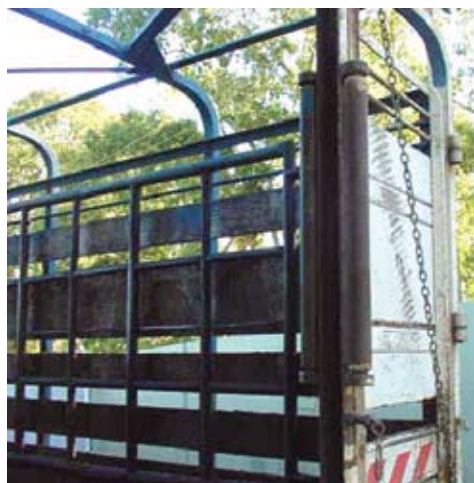
Figura 23: Rodillos funcionales colocados sobre el borde interno y externo de la puerta guillotina.
